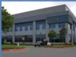
Savvis Data Center Silicon Valley
